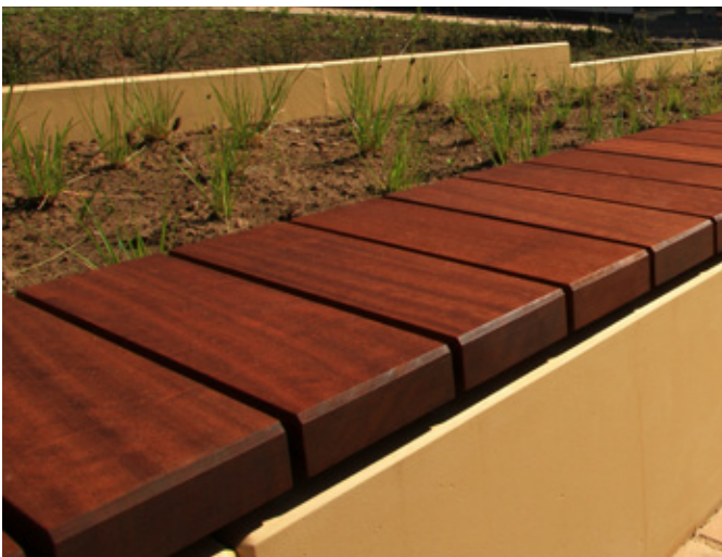
BETON MAŁOWANY PAINTED CONCRETE
